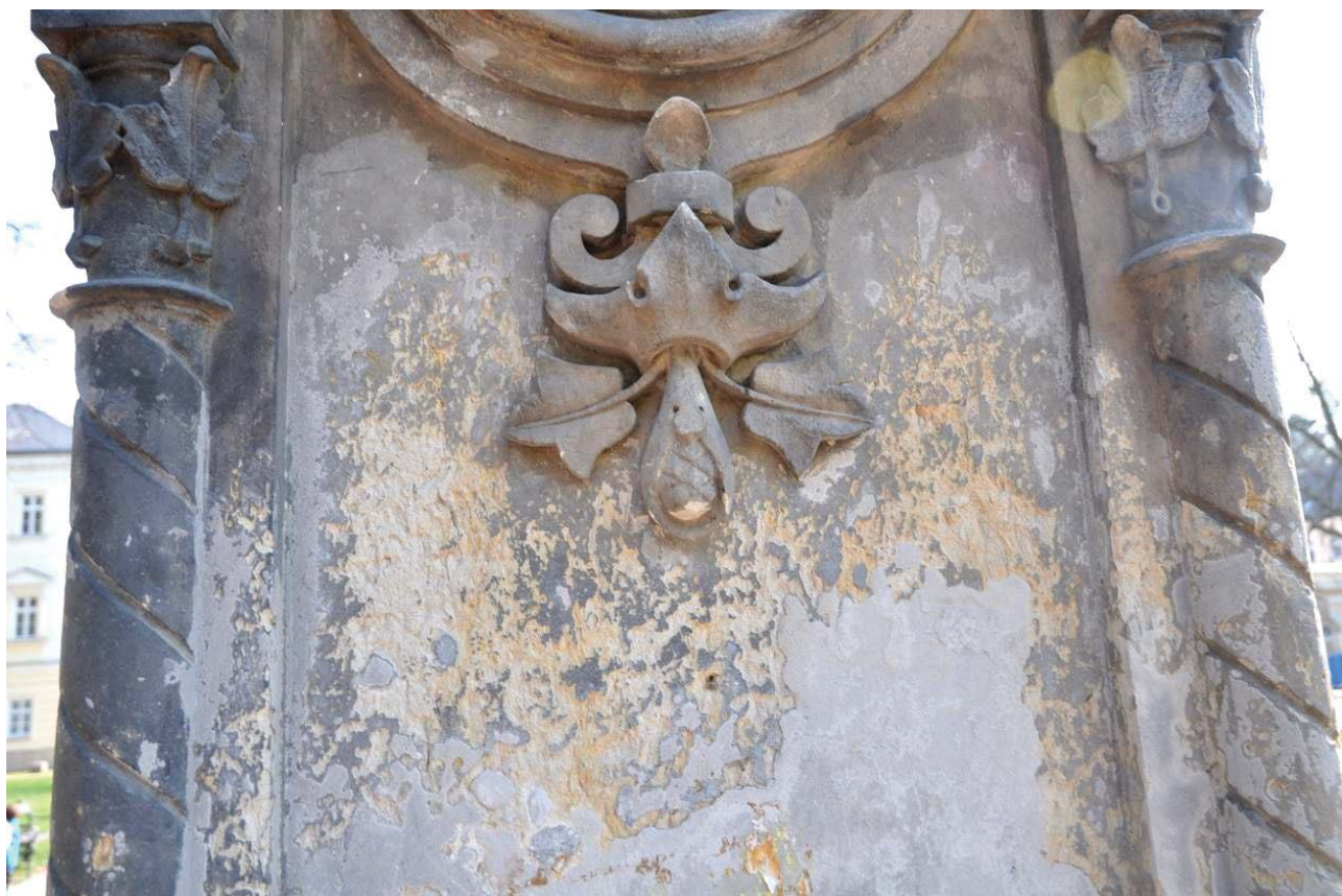
Meteosloupek-nahoře: odlupující se tenká vrstva plošného tmelu na kopuli, dole: povrchová koroze na originálních površích a v okolí plošných tmelů
