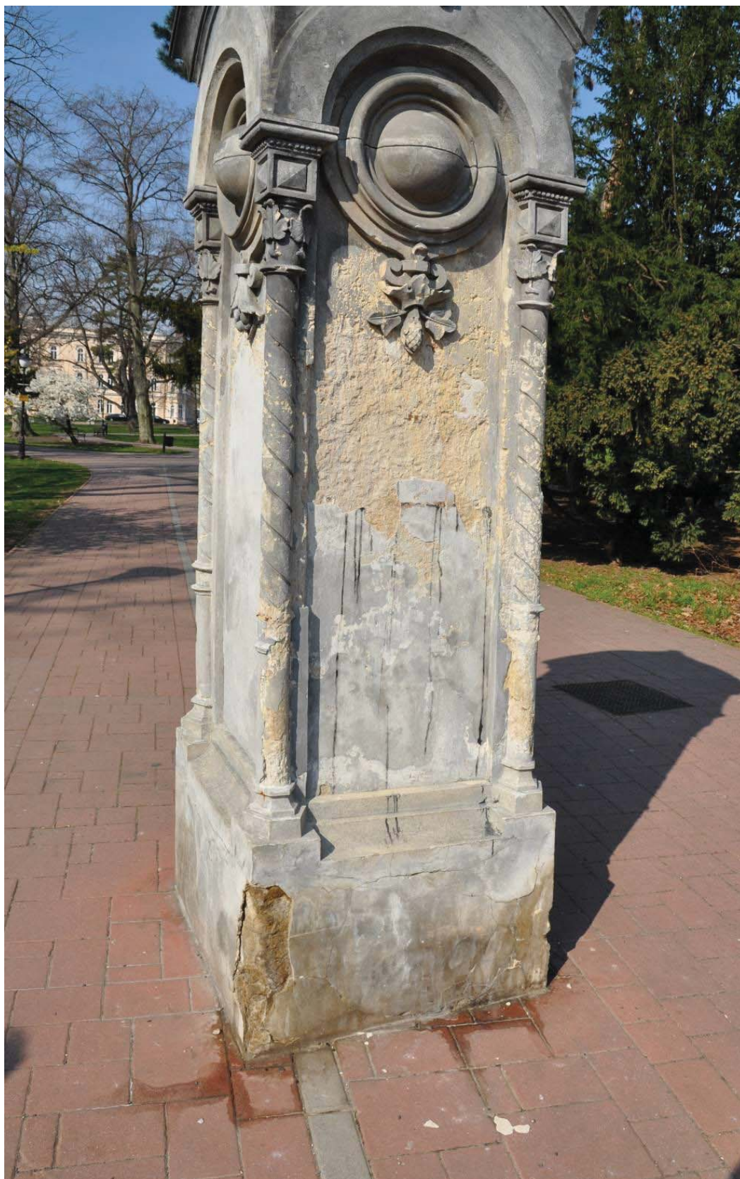
Meteosloupek- pohled na spodní část převrstvenou neprodyšnými tmely a opadávající vrstvu
