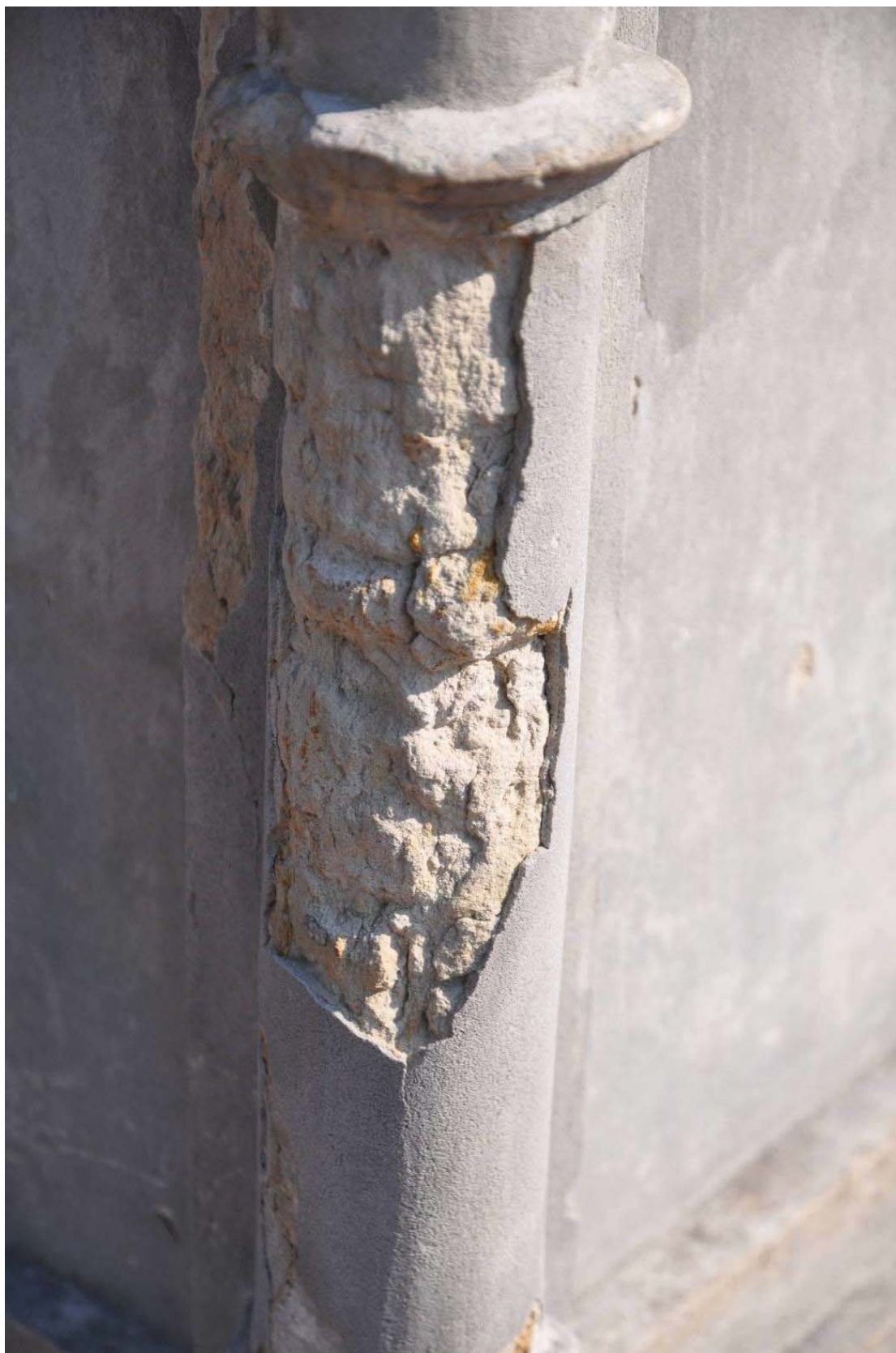
Meteosloupek-detail koroze sloupku pod neprodyšným tmelem
