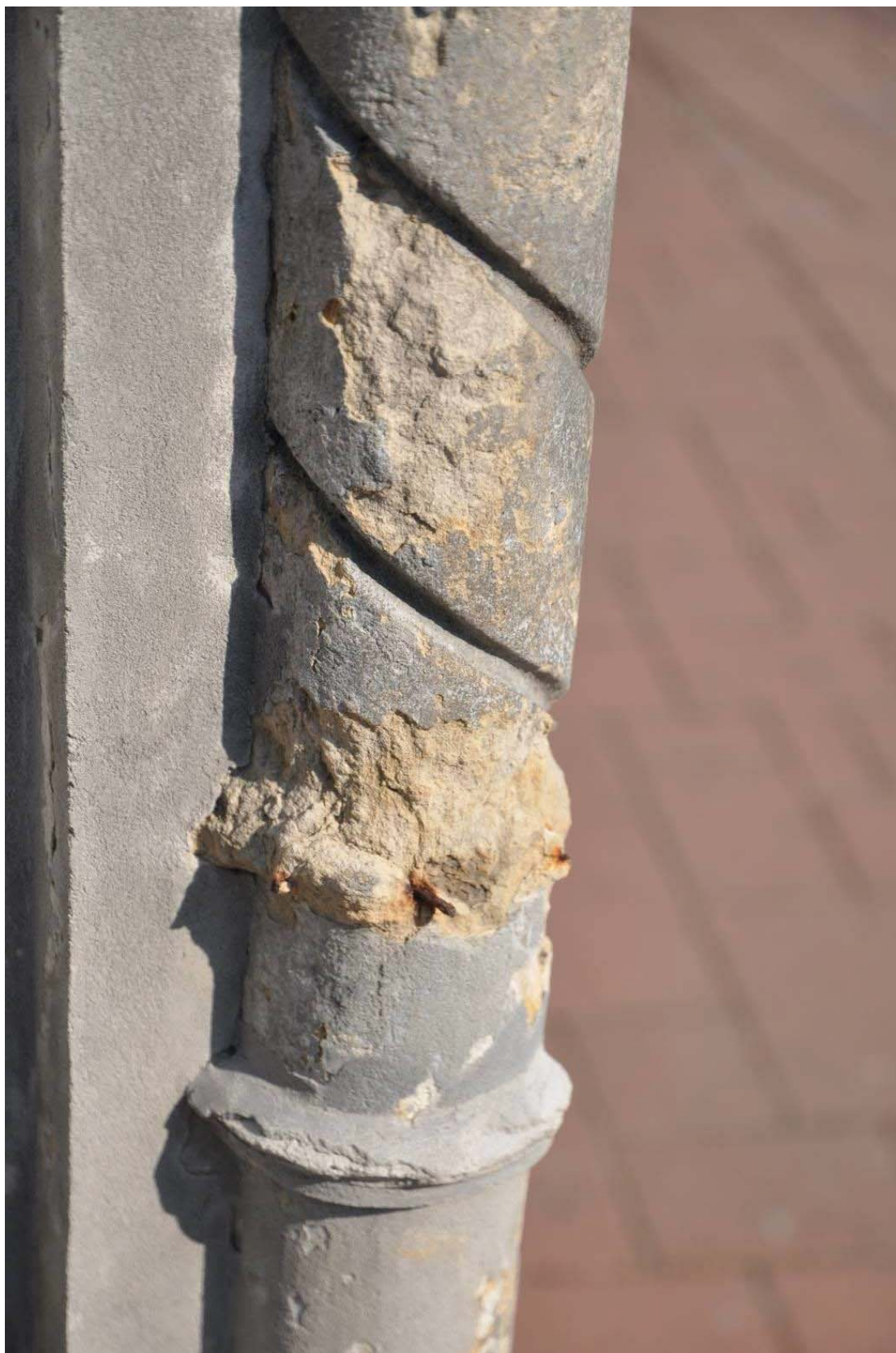
Meteosloupek- detail koroze sloupku s odpadlým tmelem po, kterém zbyly zkorodované armatury
