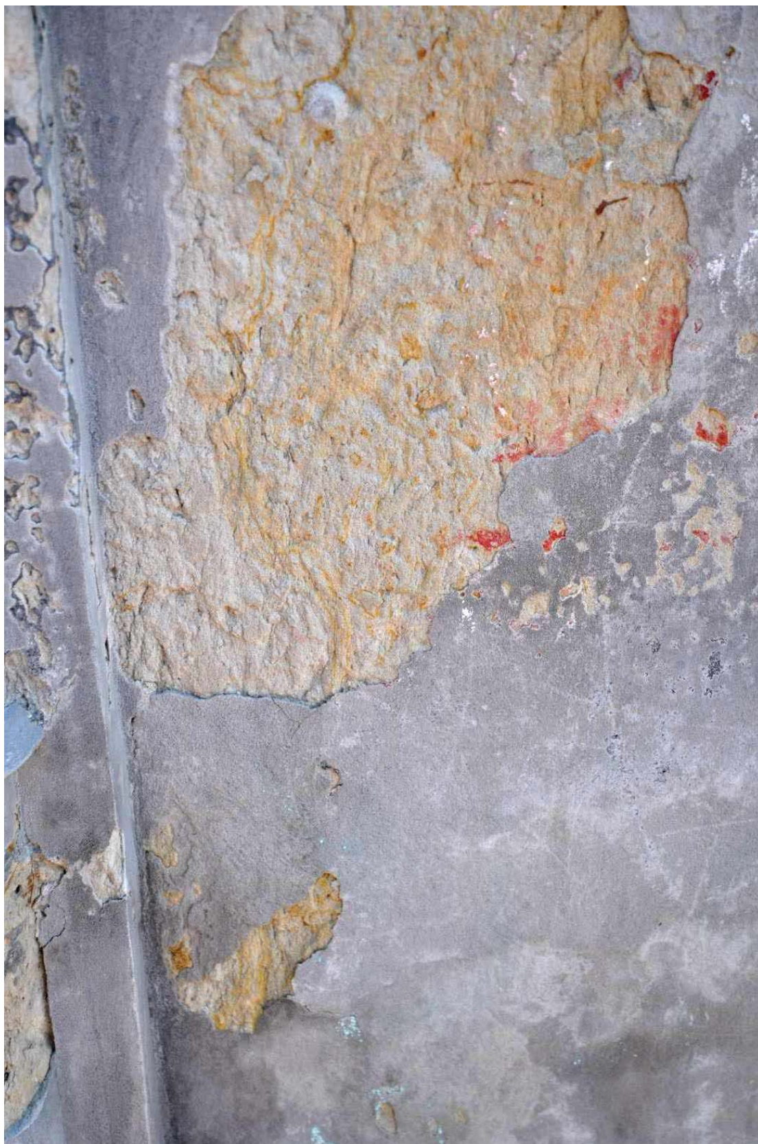
Meteosloupek- detail koroze kamene pod neprodyšnými tmely ve vpadlých polích
