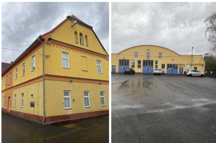
Obrázek 2 - budova administrativy a servisu trakčního vedení
