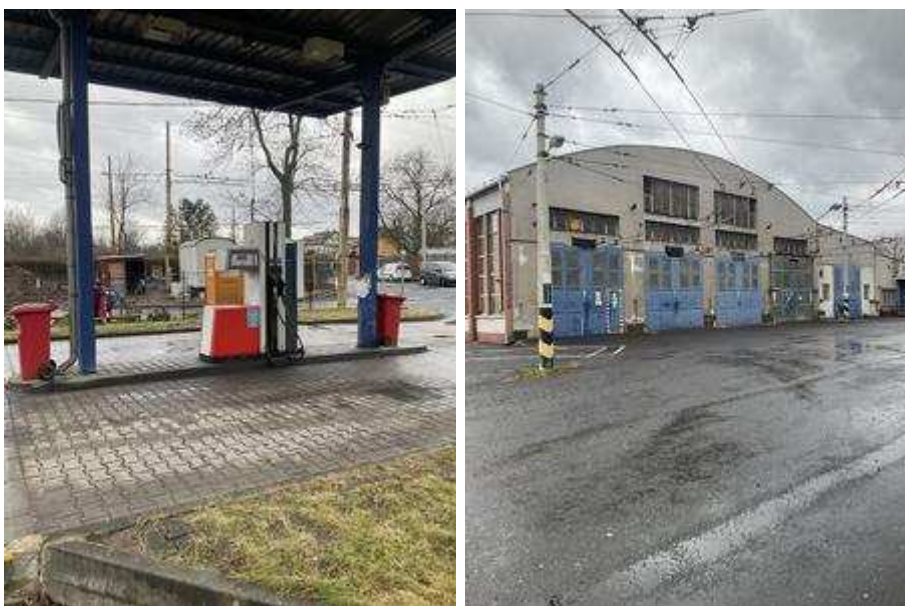
Obrázek 1 - hlavní čerpací stanice a objekt servisu
